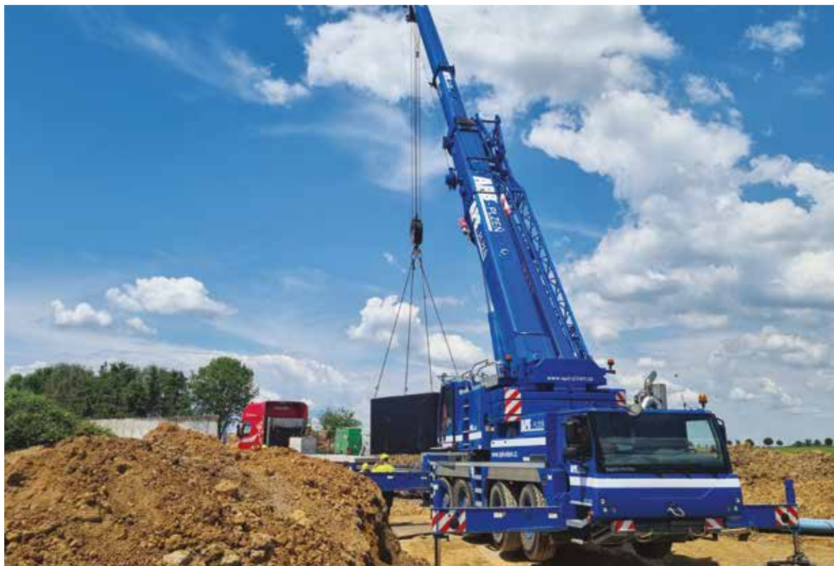
Usazování šachty pro Posázavský vodovod
