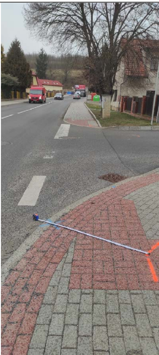
Foto 3: Vodovod vytyčený dle PD skutečného provedení stavby (oranžová barva) a vypískaný pomocí identifikačního vodiče (modrý kříž) v místě křížení ulic Psárská a Pod Vápenkou - vzdálenost mezi vytyčenými body je v tomto místě cca 1,30 m
