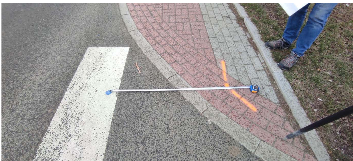
Foto 1: Vodovod vytyčený dle PD skutečného provedení stavby (oranžová barva) a vypískaný pomocí identifikačního vodiče (modrá tečka) v místě křížení ulic Psárská a Pod Vápenkou na jedné straně přechodu
