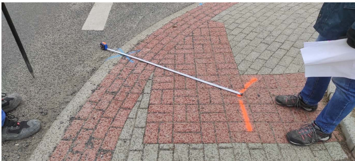
Foto 2: Vodovod vytyčený dle PD skutečného provedení stavby (oranžová barva) a vypískaný pomocí identifikačního vodiče (modrý kříž) v místě křížení ulic Psárská a Pod Vápenkou na druhé straně přechodu - vzdálenost mezi vytyčenými body je v tomto místě cca 1,30 m
