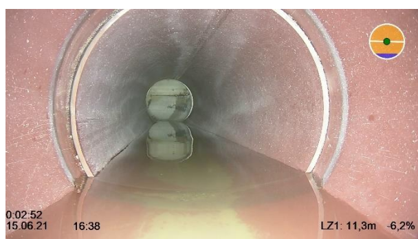
Obr. 24, 25 Průhyb potrubí na úseku ŠAA-40/ŠAA-41, potrubí lokálně v protispádu, stojící voda, spoj potrubí sanován sklolaminátovou vložkou – do kanalizace bylo zasahováno bez řádné evidence ve stavebním deníku (snímek vlevo z 15. 6. 2021 [10.5], snímek vpravo z 22. 9. 2022 [54])
