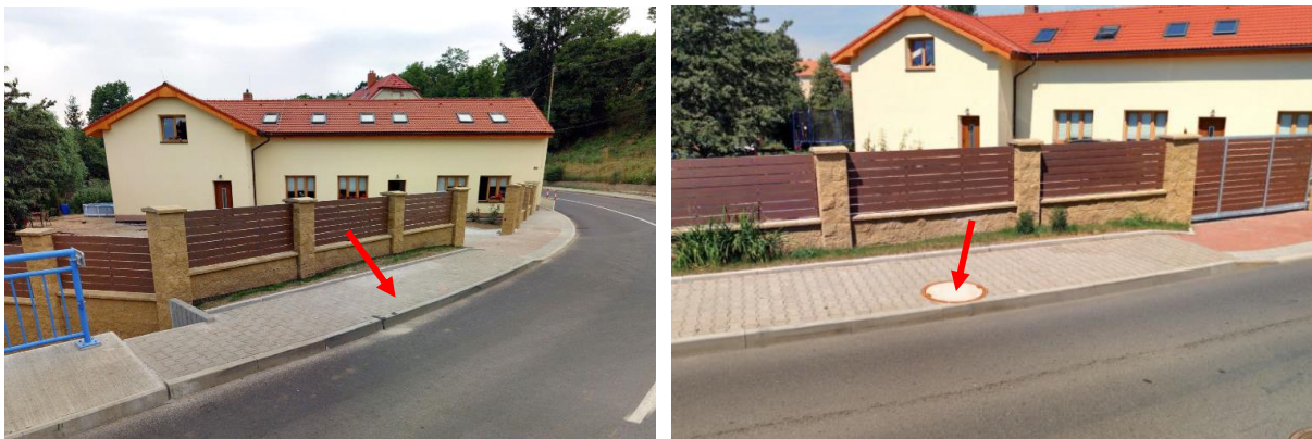
Obr. 8, 9 Lokalita šachty ŠAA-20; na snímku vlevo (z 28. 7. 2021 [102]) je nepřístupná zabetonovaná šachta, na snímku vpravo (z 4. 8. 2022 [102]) je již zpřístupněná šachta
