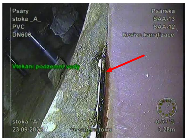
Obr. 48, 49 Nátoky balastních vod v místech spojů kanalizačního potrubí a dna revizní šachty; vlevo ŠAA-12 (23. 9 .2022 [54]), vpravo ŠAA-26 (22. 9 .2022 [54])
