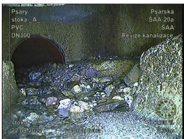
Obr. 38, 39 Nátok balastních vod v ŠAA, sedimenty na dně kynety, spára mezi dnem a skruží vadně těsněna montážní pěnou (snímky z 22. 9. 2022 [54], v rámci prvních kamerových zkoušek nebyl úsek kamerován)
