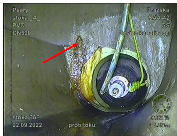
Obr. 44, 45 Zaústění stoky „A“ DN 300 do šachty ŠŠ (u zahradnictví) se dnem pro nátok potrubí DN 500, mezilehlý prostor vybetonován – výrazný nátok balastních vod, přestože byl spoj již sanován sklolaminátovou vložkou (snímek vlevo z 15. 6. 2021 [10.5], snímek vpravo z 22. 9. 2022 [54])
