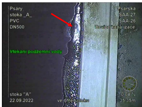
Obr. 48, 49 Nátoky balastních vod v místech spojů kanalizačního potrubí a dna revizní šachty; vlevo ŠAA-12 (23. 9 .2022 [54]), vpravo ŠAA-26 (22. 9 .2022 [54])
