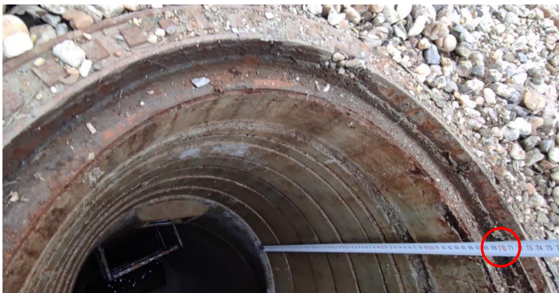
Obr. 17 Fotografie zhlaví šachty ŠAA-39 (8. 3. 2023 [99])
