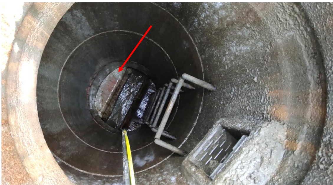
Obr. 16 Fotografie vnitřního prostoru šachty ŠAA-25a (na snímku jsou patrné inkrustace na lavičce dna, 8. 3. 2023 [99])
