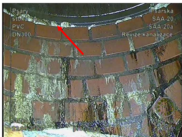
Obr. 36, 37 Masivní nátok balastních vod v ŠAA-20a (šipka zcela vlevo označuje vystřikující vodní paprsek z spáry), inkrustace na zděných stěnách dna, spára mezi dnem a skruží vadně těsněna montážní pěnou (snímky z 22. 9. 2022 [54], v rámci prvních kamerových zkoušek nebyl úsek proveden)
