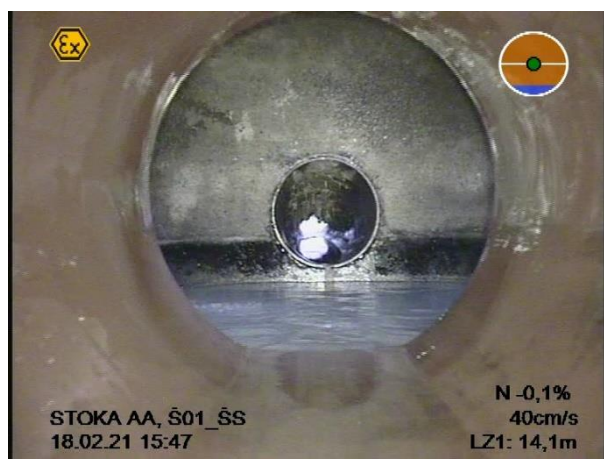
Obr. 47 Pohled do šachty ŠS u ČOV, redukce profilu potrubí z DN600 na DN300 a výše položený odtok je příčinou tvorby tlakového proudění v dolní části sběrače – není vada sběrače [10.5]
