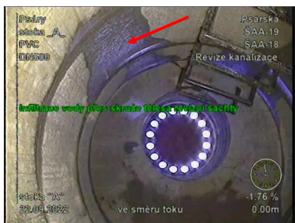
Obr. 50, 51 Průsaky balastních vod v místech spár mezi prefabrikovanými dílci (skružemi) v revizních šachtách; vlevo ŠAA-19 (22. 9 .2022 [54]), vpravo ŠAA-38 (21. 9 .2022 [54])
