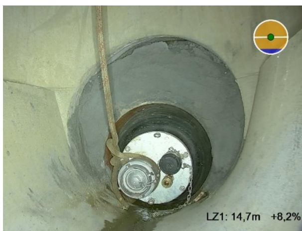
Obr. 44, 45 Zaústění stoky „A“ DN 300 do šachty ŠŠ (u zahradnictví) se dnem pro nátok potrubí DN 500, mezilehlý prostor vybetonován – výrazný nátok balastních vod, přestože byl spoj již sanován sklolaminátovou vložkou (snímek vlevo z 15. 6. 2021 [10.5], snímek vpravo z 22. 9. 2022 [54])
