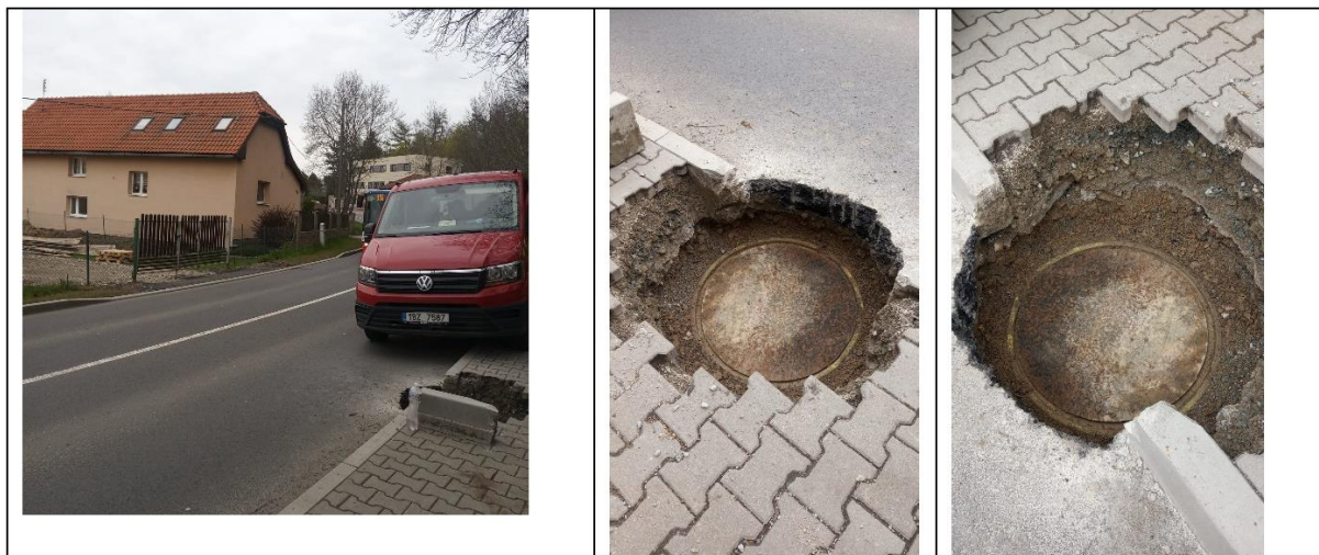
Obr. 7 Fotografie z provádění zásahu do zhlaví šachty dešťové kanalizace (20. 4. 2022 [37]), do té doby zakrytá a nepřístupná revizní šachta
