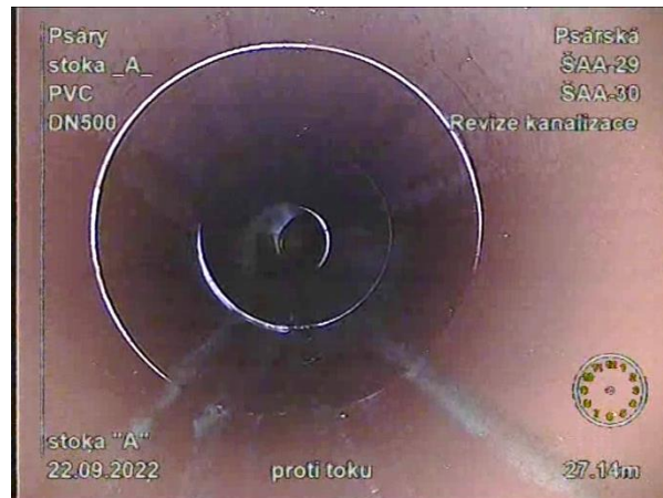
Obr. 32, 33 Porovnání snímků z úseku s opticky zvýšenou ovalitou (ŠAA-29/ŠAA-30), ovalita dle protokolů: 03/2021 = cca 0-5 %, 09/2022 = cca -5-10 %; nedochází k zásadní progresi ovality (snímek vlevo z 14. 4. 2021 [10.5], snímek vpravo z 22. 9. 2022 [54])
