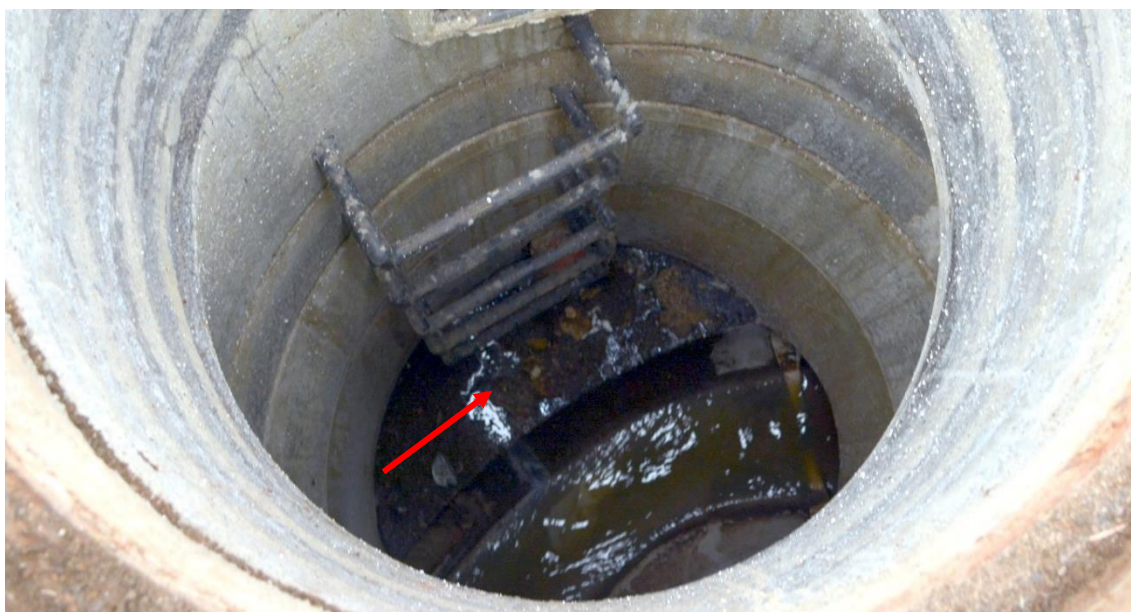
Obr. 18 Fotografie vnitřního prostoru šachty ŠAA-19 (na snímku je patrné potrubí přípojky pod stupadly a nátok balastní vody, 8. 3. 2023 [99])
