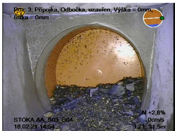
Obr. 34, 35 Záslepený nátok pro stoku „E“ v ŠAA-04 (snímek vlevo z 18. 2. 2021; snímek vpravo z 8. 3. 2021 [10.5]); na snímku vpravo proražená záslepka a nátok balastních vod; k 09/2022 [54] je stoka „E“ napojena na ŠAA-04 (napojení již opravováno sklolaminátovou vložkou)
