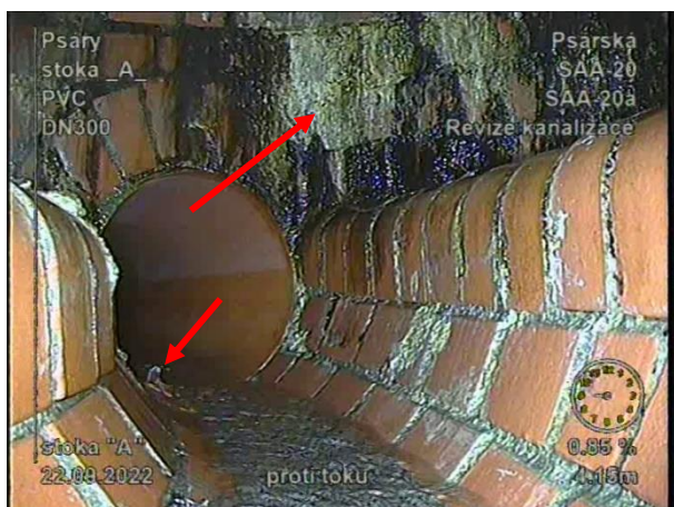
Obr. 36, 37 Masivní nátok balastních vod v ŠAA-20a (šipka zcela vlevo označuje vystřikující vodní paprsek z spáry), inkrustace na zděných stěnách dna, spára mezi dnem a skruží vadně těsněna montážní pěnou (snímky z 22. 9. 2022 [54], v rámci prvních kamerových zkoušek nebyl úsek proveden)
