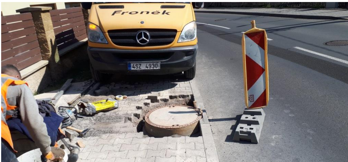
Obr. 10 Fotografie z provádění zásahu do zhlaví ŠAA-20, vybourání a zpřístupnění šachty (snímek z 23. 4. 2022 [40]), do 19. 4. 2022 zakrytá a nepřístupná revizní šachta [85]
