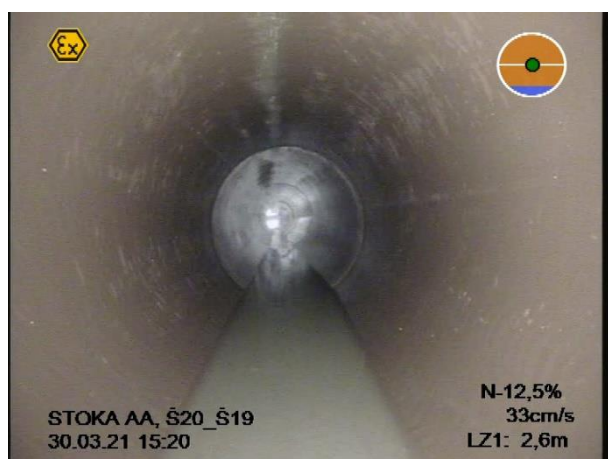
Obr. 26, 27 Průhyb potrubí na úseku ŠAA-19/ŠAA-20, potrubí lokálně v protispádu, stojící voda, na snímku z 09/2022 jsou patrné sedimenty na dně (snímek vlevo z 30. 3. 2021 [10.5], snímek vpravo z 22. 9. 2022 [54])
