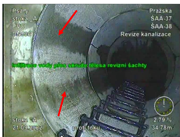
Obr. 50, 51 Průsaky balastních vod v místech spár mezi prefabrikovanými dílci (skružemi) v revizních šachtách; vlevo ŠAA-19 (22. 9 .2022 [54]), vpravo ŠAA-38 (21. 9 .2022 [54])
