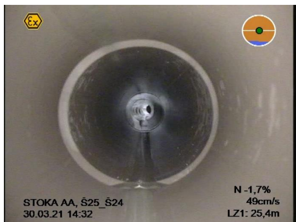
Obr. 30, 31 Porovnání snímků z úseku s opticky zvýšenou ovalitou (ŠAA-24/ŠAA-25), ovalita dle protokolů: 03/2021 = cca 0-5 %, 09/2022 = cca -6-9 %; nedochází k zásadní progresi ovality (snímek vlevo z 30. 3. 2021 [10.5], vpravo z 22. 9. 2022 [54])
