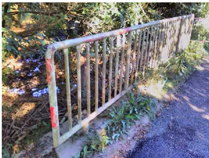
pohled na zábradlí
