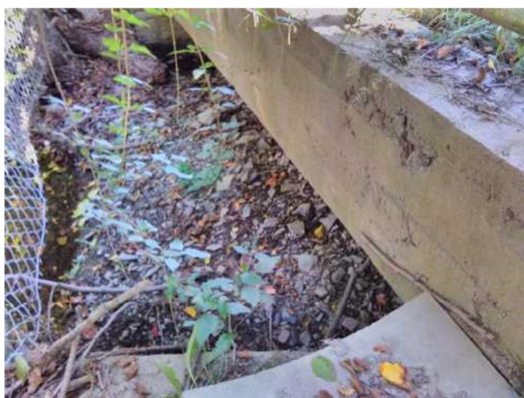
pohled na bok mostu
